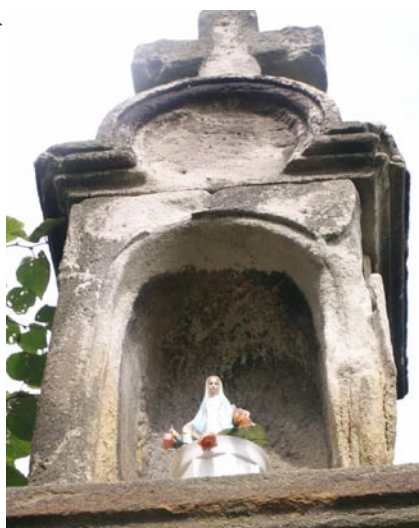
Kapliczka Niezgodów: stan przed remontem (znaczne ubytki, nagromadzona przez lata czarna patyna) i efekt końcowy
