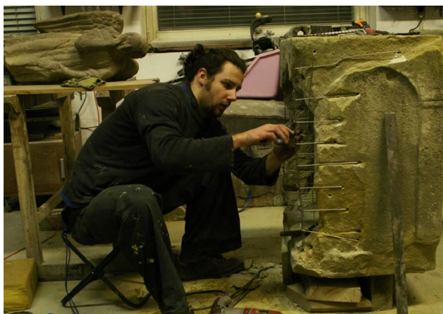
Lubosz Karwat ratuje kapliczkę ufundowaną przez małżeństwo Niezgodów z Brzostka w 1881 r. – druciane rusztowania podtrzymują dobudowywane uzupełnienia
