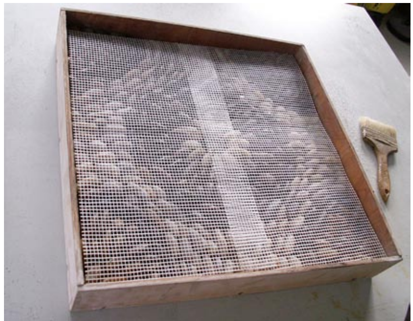
Docinamy i układamy siatkę zbrojeniową, pozostawiając około 1 cm miejsca od boków skrzynki.
