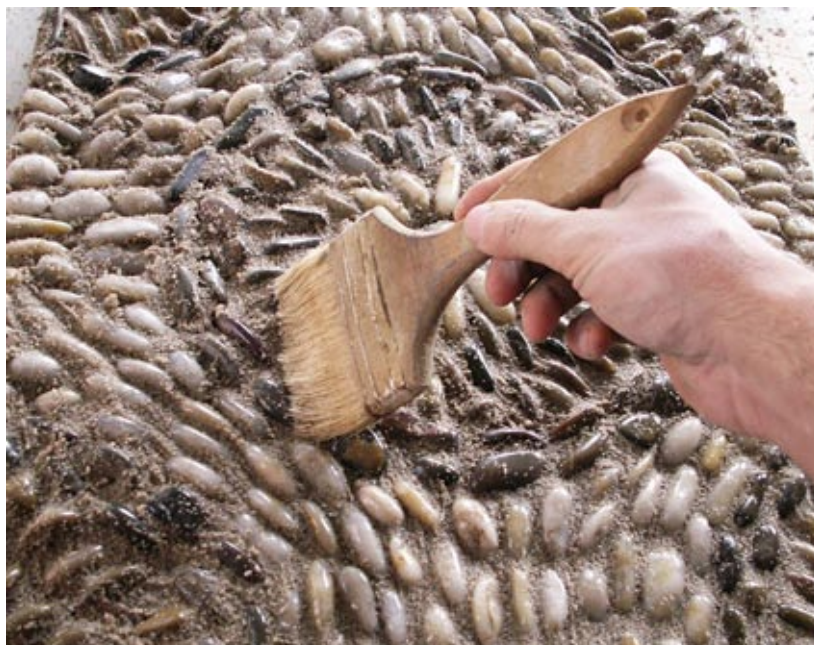
Kiedy zaprawa zwiąże, możemy odwrócić skrzyneczkę, wyjąć mozaikę i usunąć pozostały piasek...
