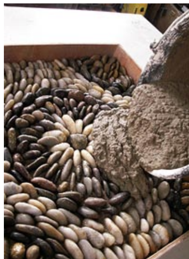
Wlewamy do skrzynki zaprawę...
