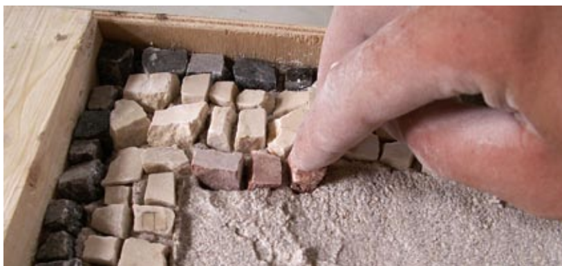
I zaczynamy zabawę z wciskaniem tesserów w zaprawę
