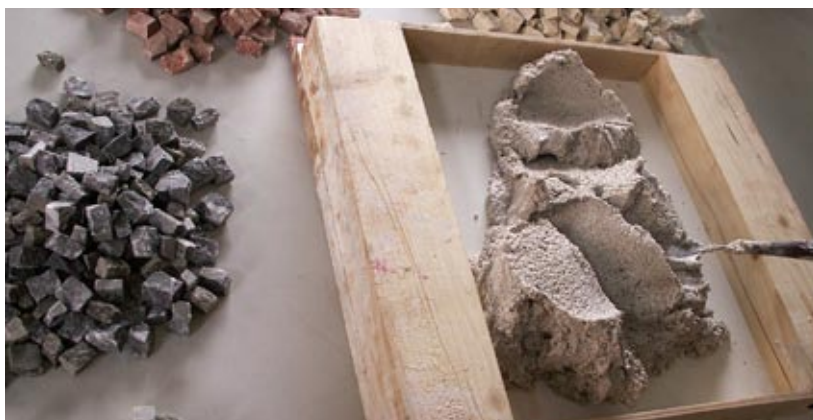
Rozrobioną zaprawę wlewamy w naszą skrzyneczkę, dobrze jest dać siatkę zbrojeniową na jej dno
